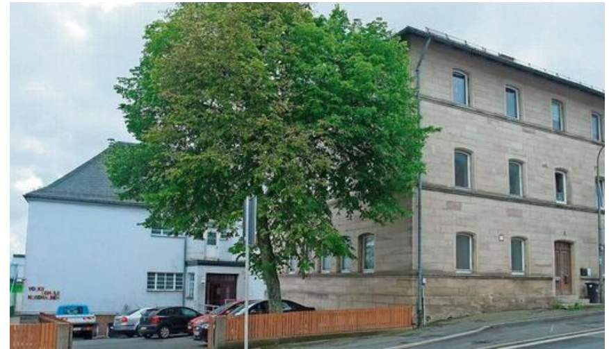
Die alte Schule (Sandsteingebäude) und der Zwischentrakt (weiß) soll "Nordhalben Village" beherbergen - eine Art Gründerzentrum in Nordhalben.
